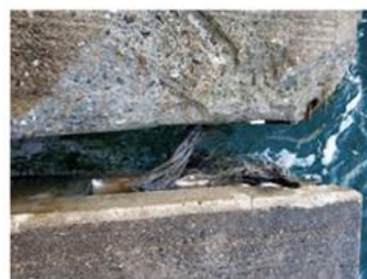
Rotura de la conexión
