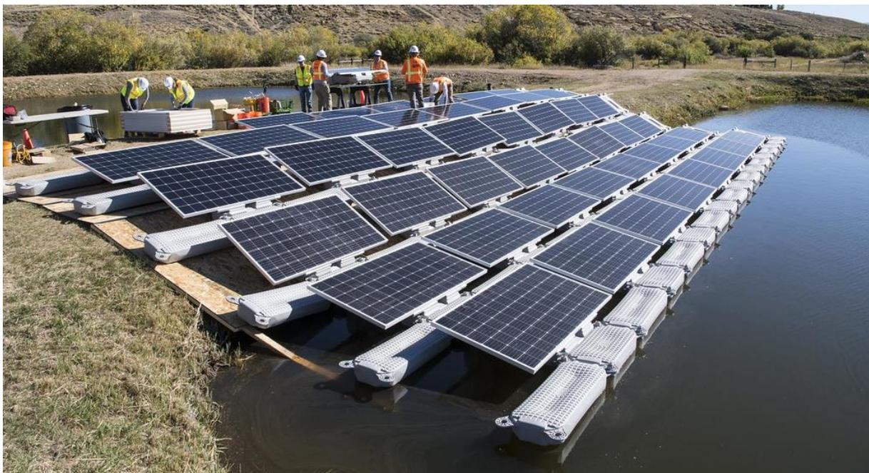
Figura 1 - Instalación de paneles solares flotantes rígidos en Walden, Colorado (fuente: US Department of Energy).
