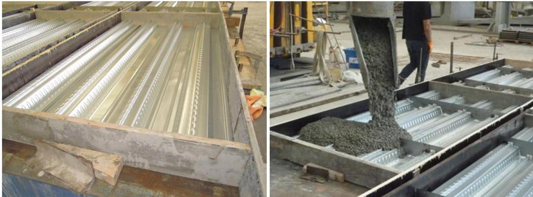
Figura 5. Fabricación de los forjados mixtos
