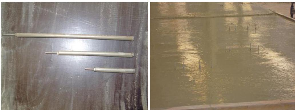
Figura 8. Tubos utilizados (izquierda) y ubicación en la losa (derecha)
